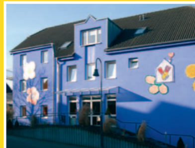
Haus Aachen, Eröffnung 17.12.1991
